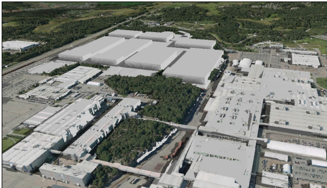
Figur 5. Vy från sydost över möjlig industrietablering inom detaljplaneområdet (Bild: Göteborgs stad).
